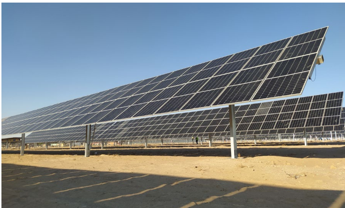
Рисунок 14. Установка солнечных панелей
